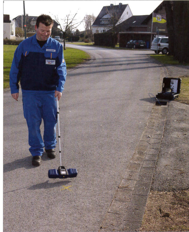
Exaktes Orten der Funkwellen des Kamerakopfes Wöhler VIS 350 durch Beton und Asphalt erspart eine Menge Zeit und Bauschäden.
